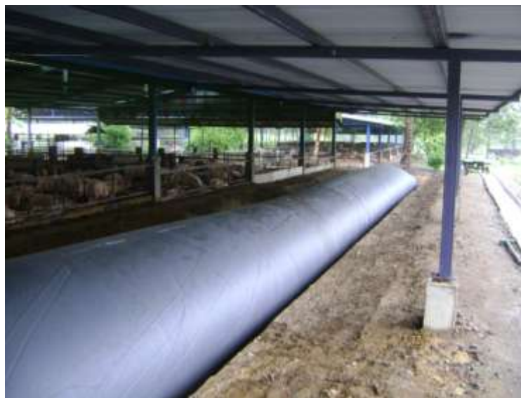
Reservorio de biogás “limpio”
